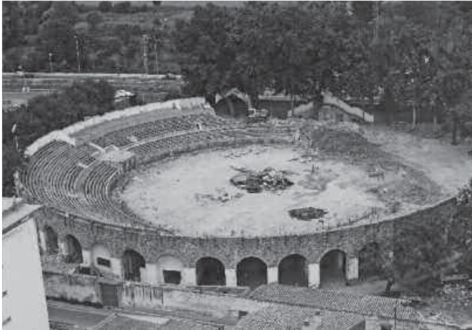
Demolizione dell'arena di Girona, agosto 2006.
